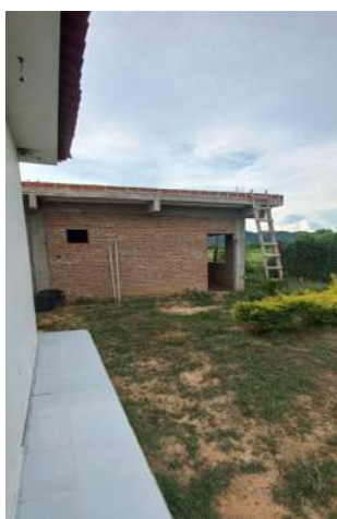
Construcción de infraestructura y las baterías de baños para los niños de la unidad educativa 29 de junio
