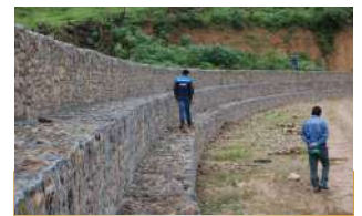
"Construcción de Defensivos de Gavión "
