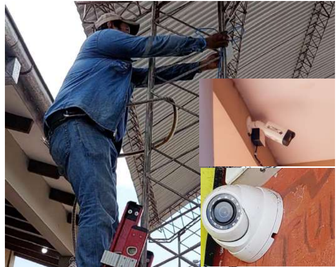
Personal Técnico del G.A.M.E.T. haciendo instalacion de camara de seguridad
