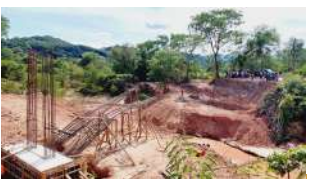
Construcción Puente Vehicular La Elvira
