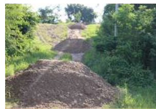
Mant. Caminos Vecinales Barrio La Fortaleza
