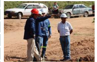
MANT. DE CAMINO VECINAL COMUNIDAD CAÑADA STRONGET DIST. 2
