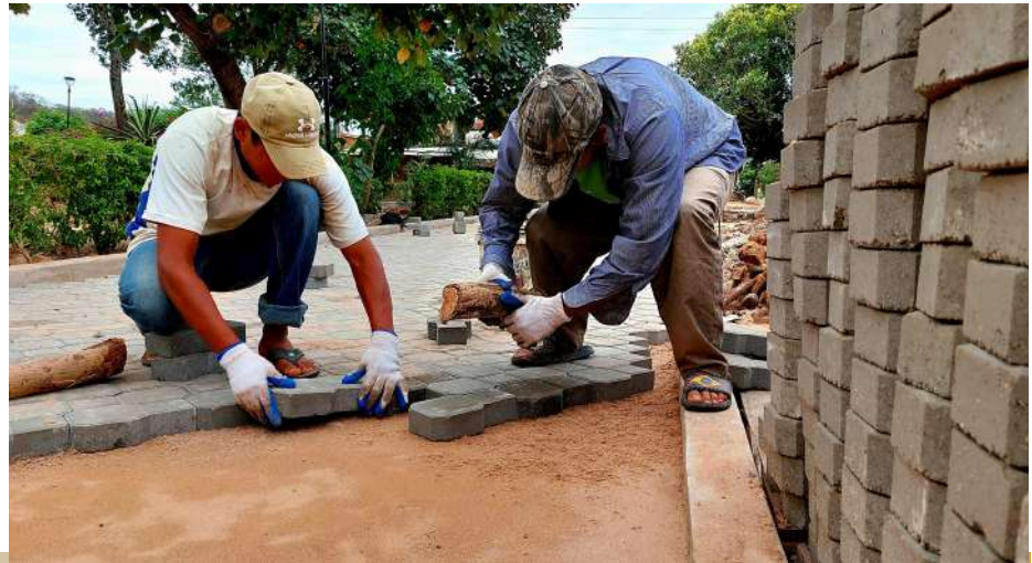
Trabajos de mejoramiento de la plaza principal la angostura Distrito 5
