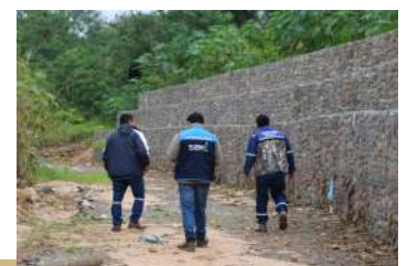
Defensivos en las riveras del río pirai de gavión que permiten controlar las crecidas del río
