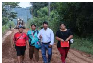
Mantenimiento de Camino Vecinal
