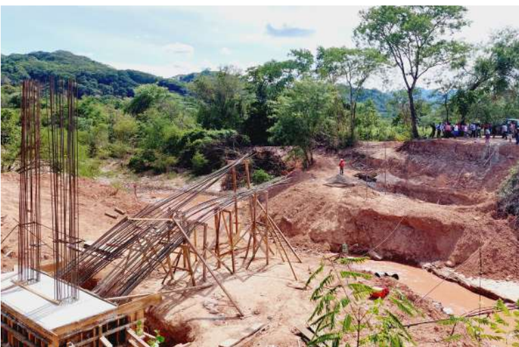
Inspección a la construcción Puente Vehicular Quebrada La Elvira D-4
