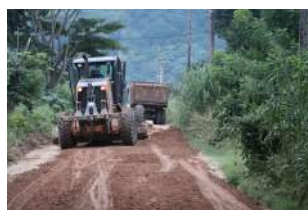
Mantenimiento de Camino Vecinal Distrito -3
