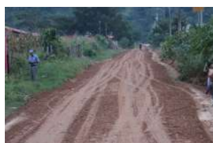
Mantenimiento de Camino Vecinal Distrito -3
