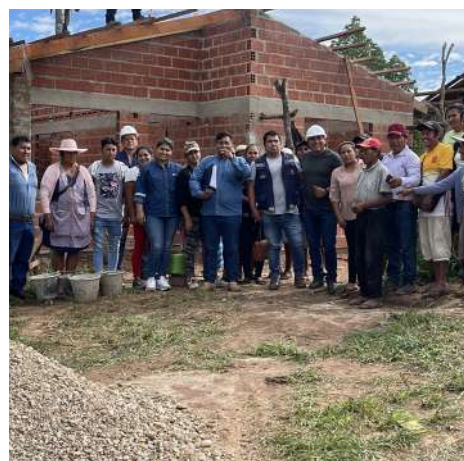
Colocado de piedra fundamta de proyecto de Vivienda Social
