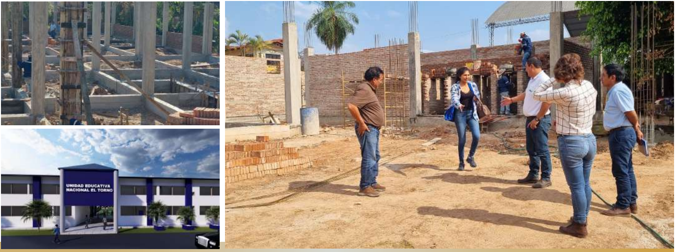
Inspección a la construcción Unidad Educativa Nacional El Torno
