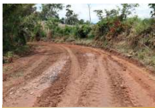
Mantenimiento de Camino Vecinal San Matias de Lomerio
