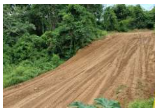
Mantenimiento de Camino Vecinal
