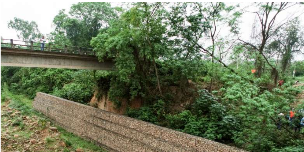
Defensivos en las riveras del río pirai de gavión que permiten controlar las crecidas del río
