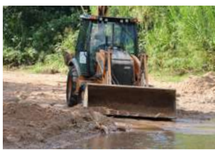
Mantenimiento de Camino Vecinal Quebrada Leon
