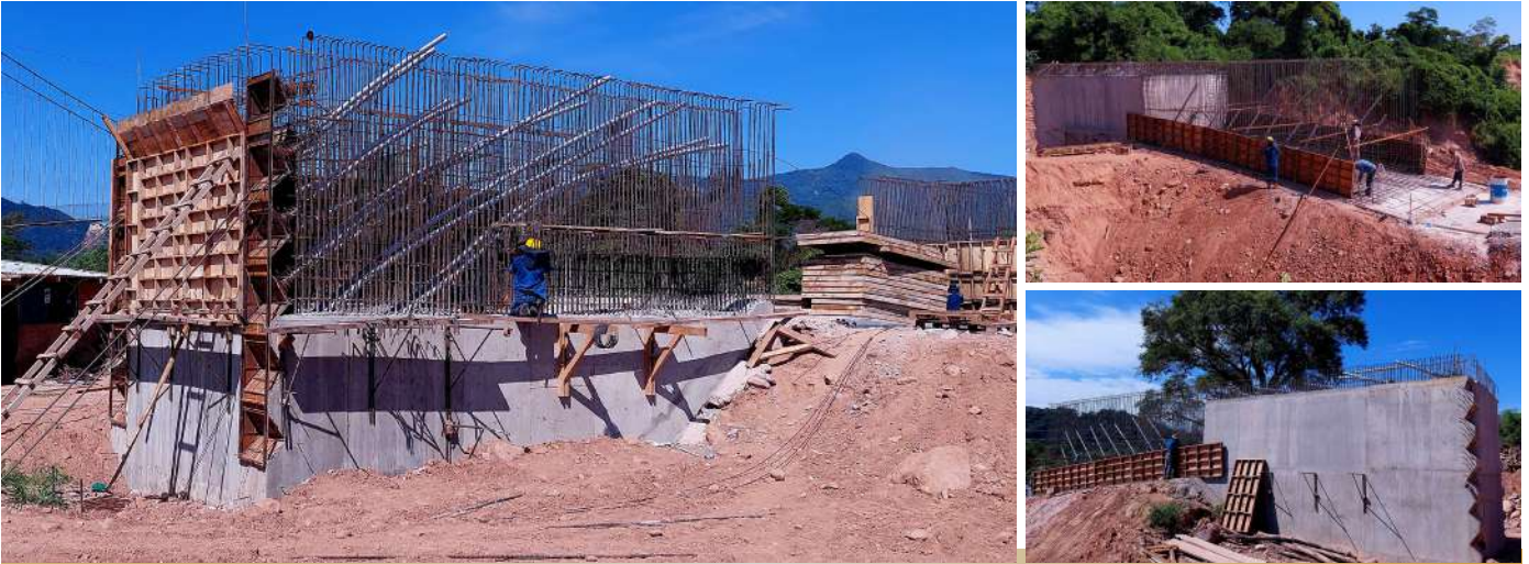
Inspección a la construcción Puente Vehicular San Luis - Villa Florida - El Torno
