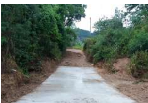
Construccion de Baden La Forestal
