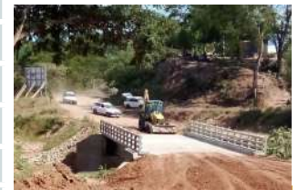
CONST. PUENTE VEHICULAR LAS MARAS DIST. 2
