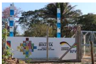
Sistema de Agua Potable San Luis - Tarumá
